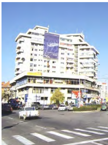
Pitești, 16 noiembrie 1989. Casa Cărții și Casa Artelor, șef de șantier, Ion C. Vasiliu (inaugurare parțială).
