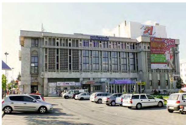
Clădirea Teatrului Alexandru Davila după reconfigurarea din 1977-1979
